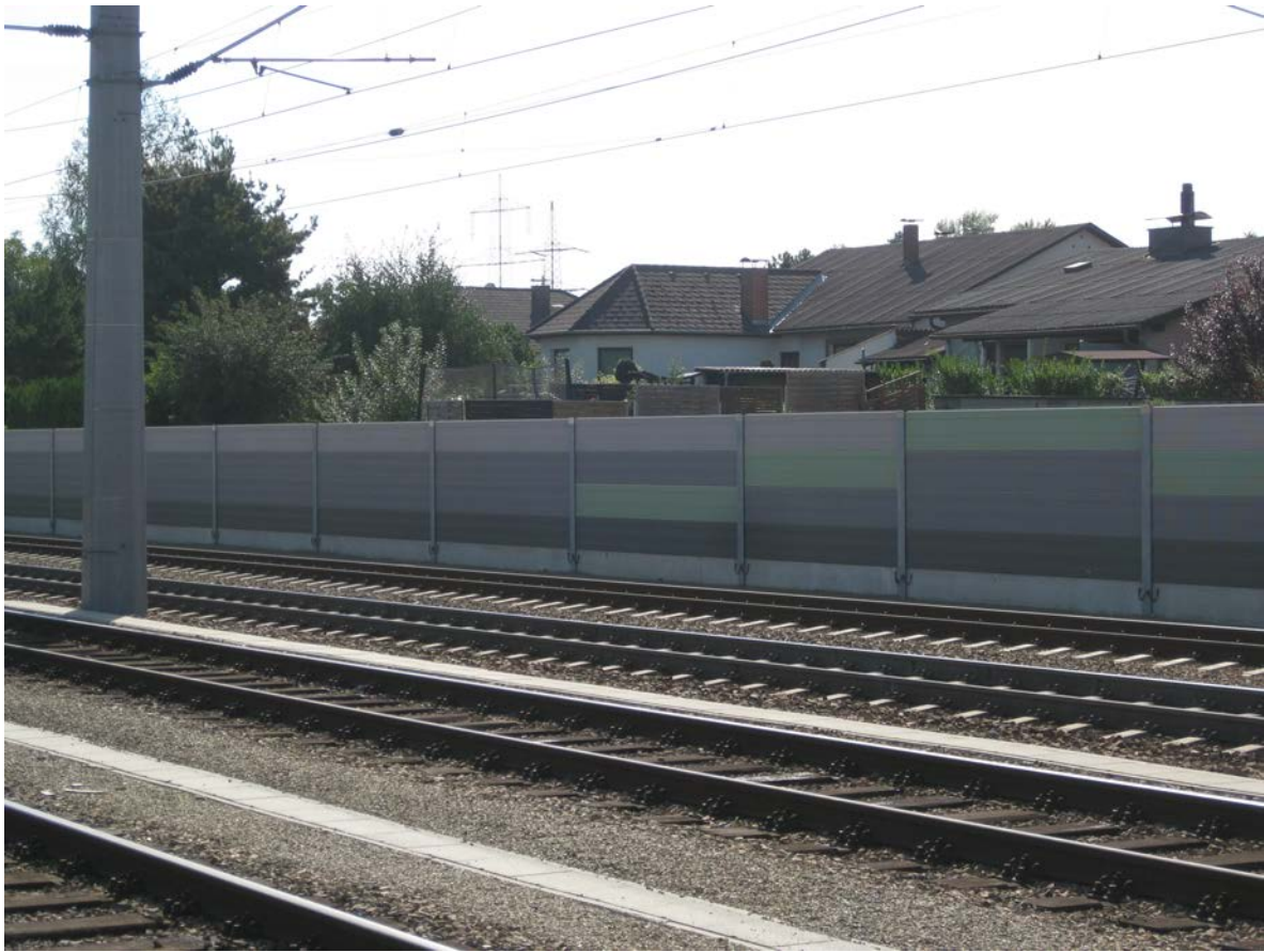
Abbildung 5 Lärmschutzwand zum Schutz eines Siedlungsgebietes, Quelle: ÖBB-Infrastruktur AG
