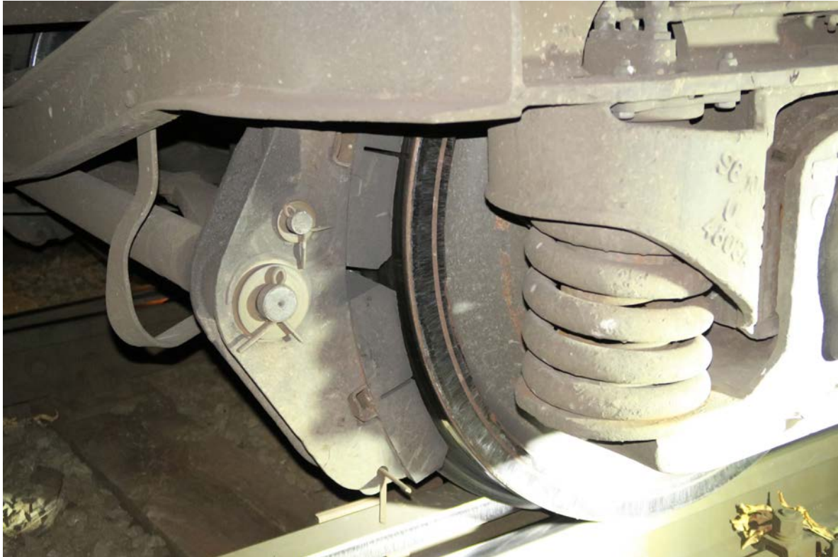
Abbildung 6 Bremssohle eines Güterwagens, Quelle: ÖBB-Infrastruktur AG
